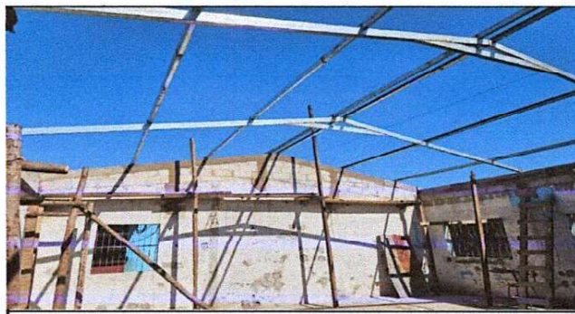
Foto 5: Colocación de la estructura metalica para el techo de las dos aulas.
